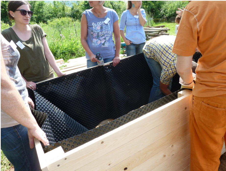
Abb. 3: Befestigung der Noppenfolie (hier mit Reißnägeln)
